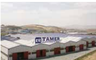
Tamer Kalıp ve İskele Fabrika Tamer Kalıp ve İskele Factory
