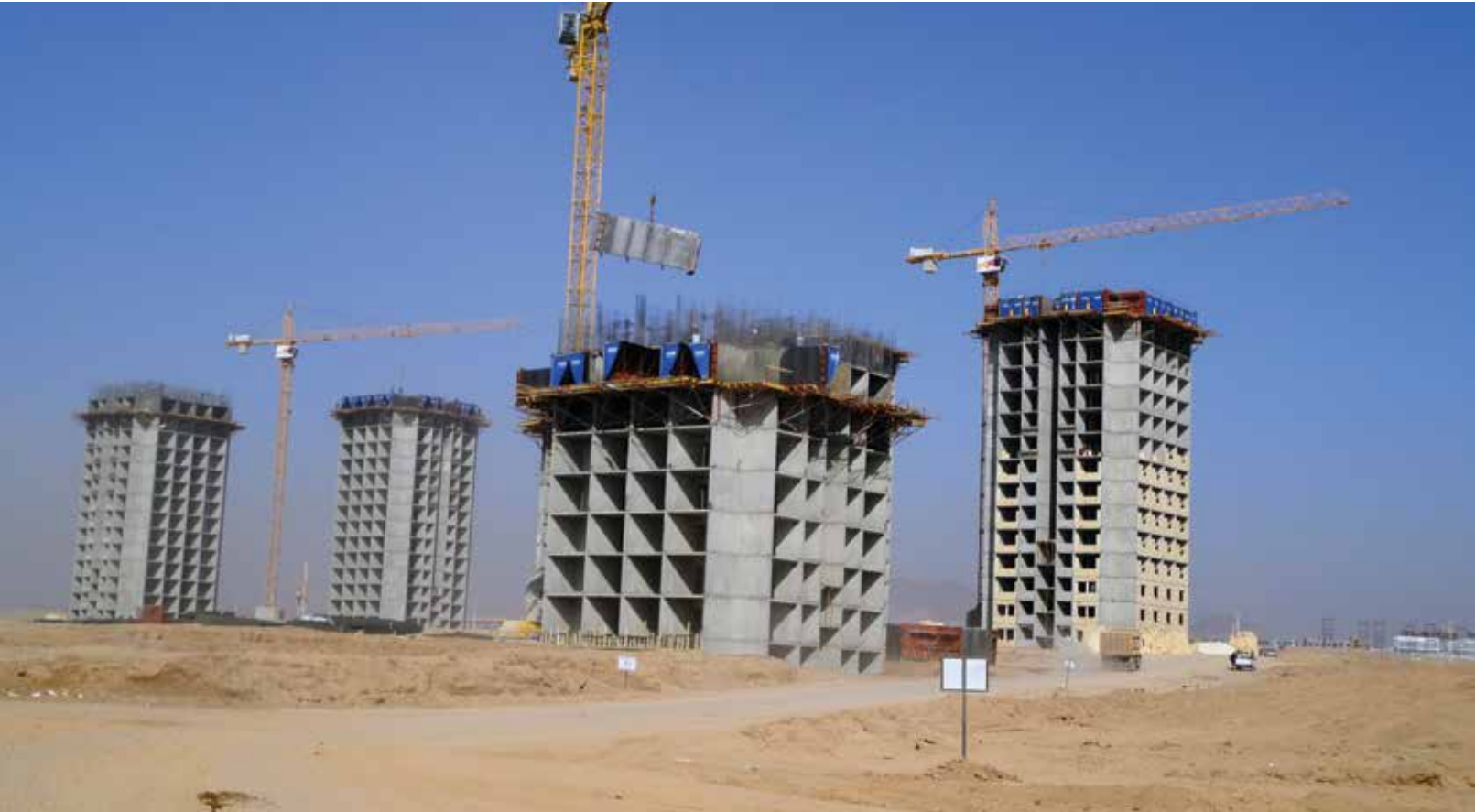
ESKİHİSAR İNŞAAT - PARAND / İRAN
