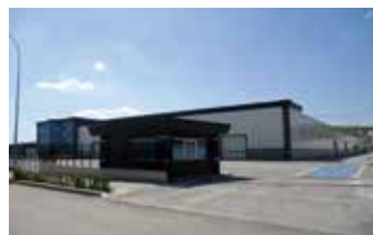
Sonbay Boru 2. Fabrika Sonbay Boru 2. Factory
