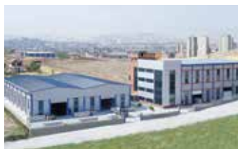
Sonbay Boru 1. Fabrika Sonbay Boru 1. Factory
