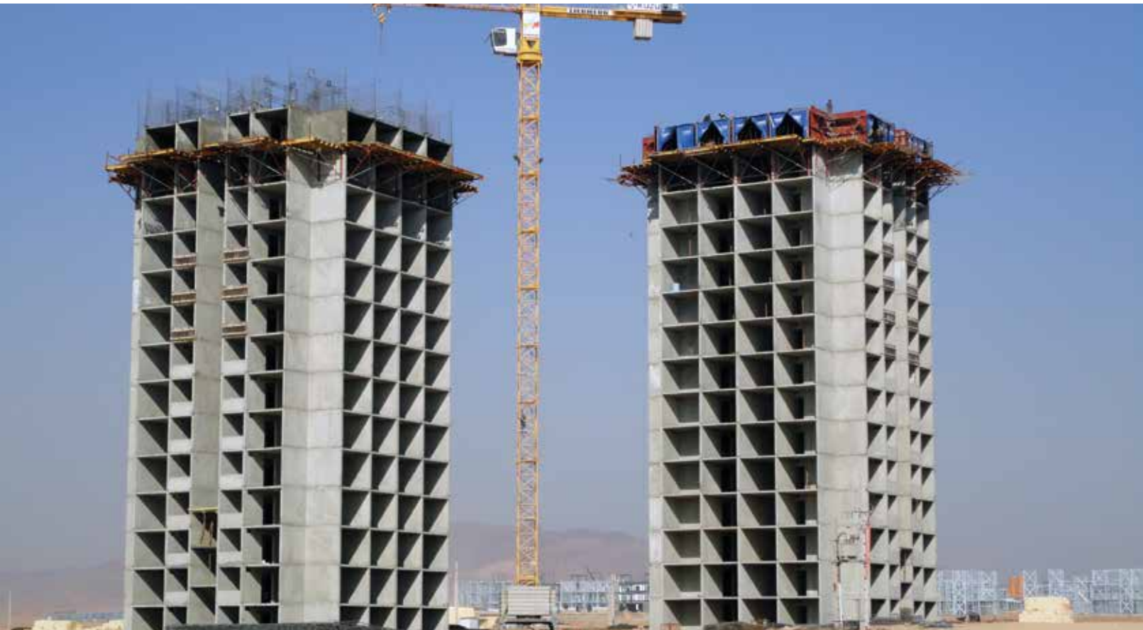
ESKİHİSAR İNŞAAT - PARAND / İRAN
