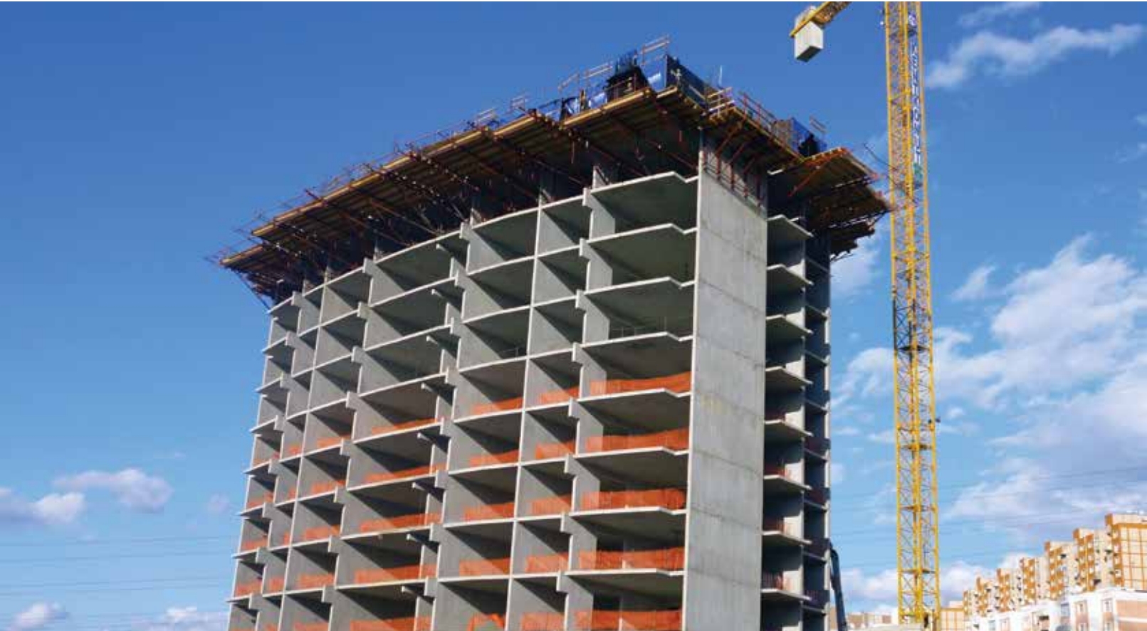
HALDIZ İNŞAAT - Kent Koop Konutları - KOCAELİ / Kentkoop Houses - Kocaeli
