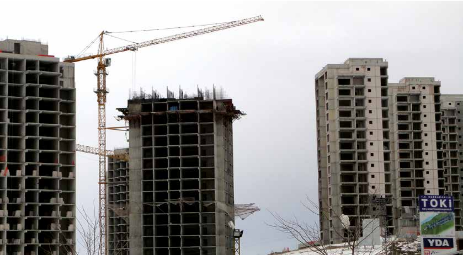
AKSAY İNŞAAT - İncek TOKİ Konutları / İncek Toki Houses
