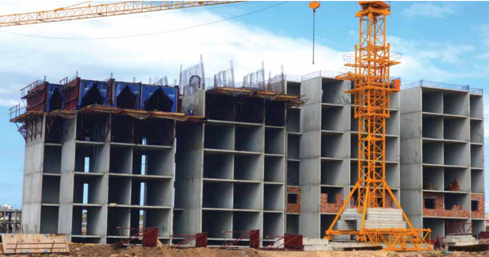
ASLAN İNŞAAT 18.000 Konut - Cezayir / Algeria Houses
