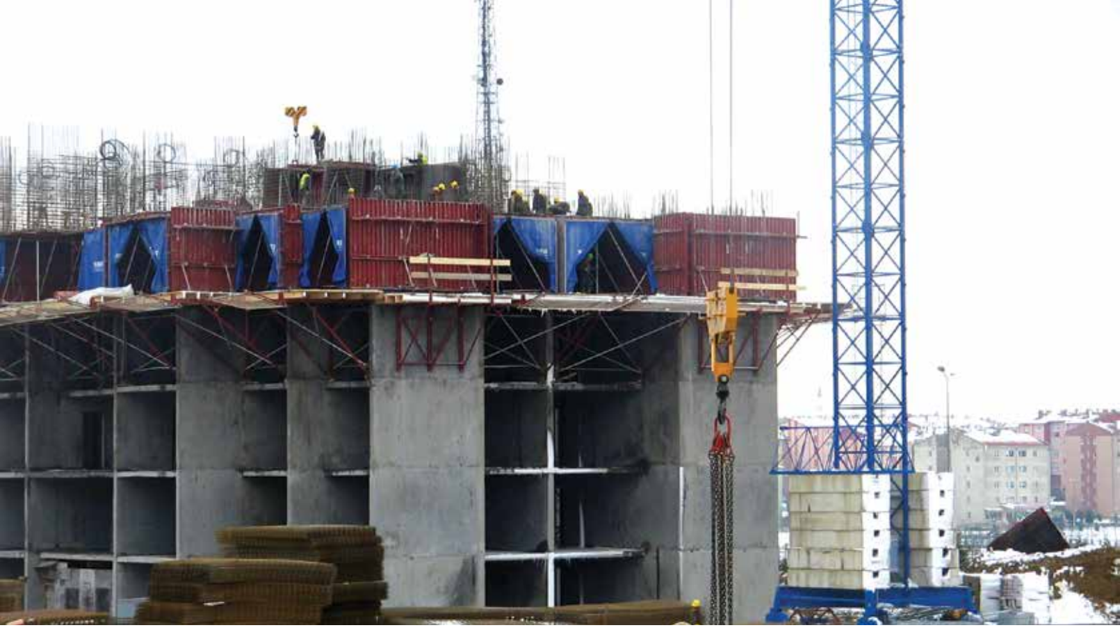
KENT - İstanbul Metrokent Konutları / Istanbul Metrokent Houses
