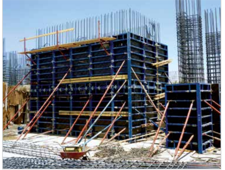
AÇILI L PERDE BİRLEŞİMİ / ANGULAR L WALL DETAIL
