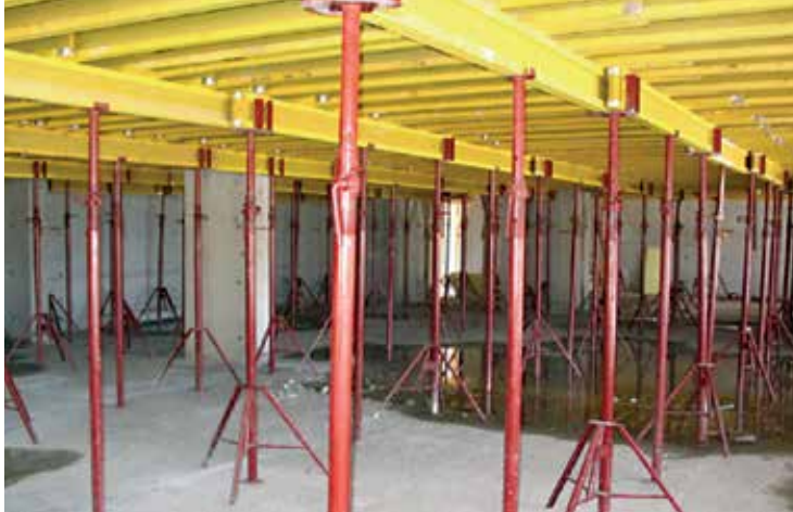
KİRİŞ ALTI BAŞLIKLİ TELESKOBİK DİKME BEAM FORMING HEAD TELESCOPIC PROP
